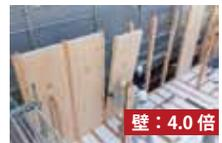
頑強な木組構造を耐力壁（壁パネル）で支える軸組パネル工法を採用。強度の倍率は一般的な在来工法との比較、木材量も2倍以上！
